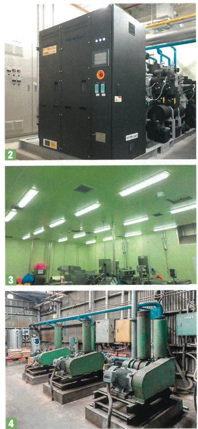
2 自然冷媒を使用した冷凍機に切り替え
